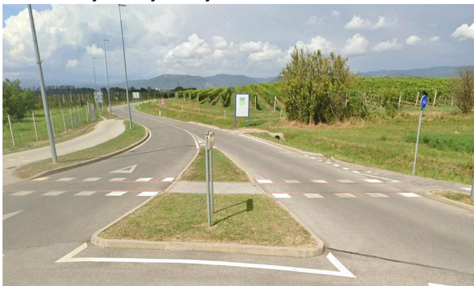
Slika 6: Obstoječe stanje – zaključek odseka
